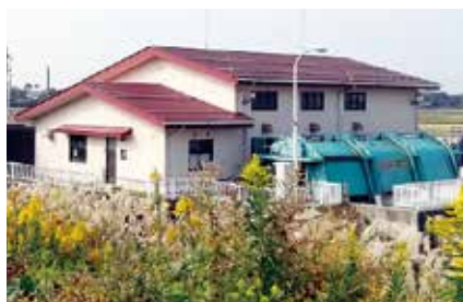
国中排水機場
